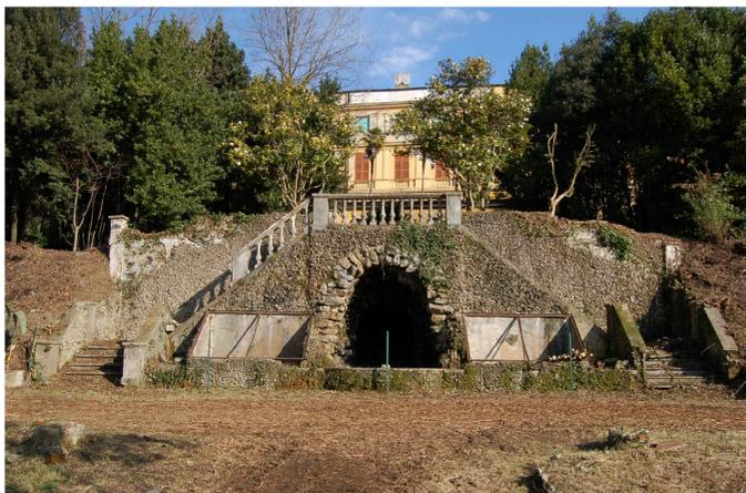
Foto 7): Il ninfeo e la doppia scalinata monumentale in avanzato stato di degrado la balaustra risulta in gran parte persa
